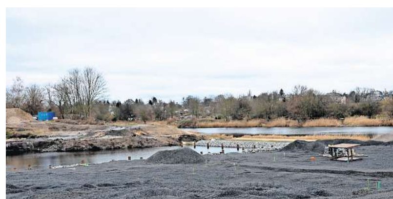
Um den Hafenausbau wird nach wie vor leidenschaftlich gestritten. Unterdessen gehen die Bauarbeiten planmäßig voran. FOTO: STEPHAN LAUDE
