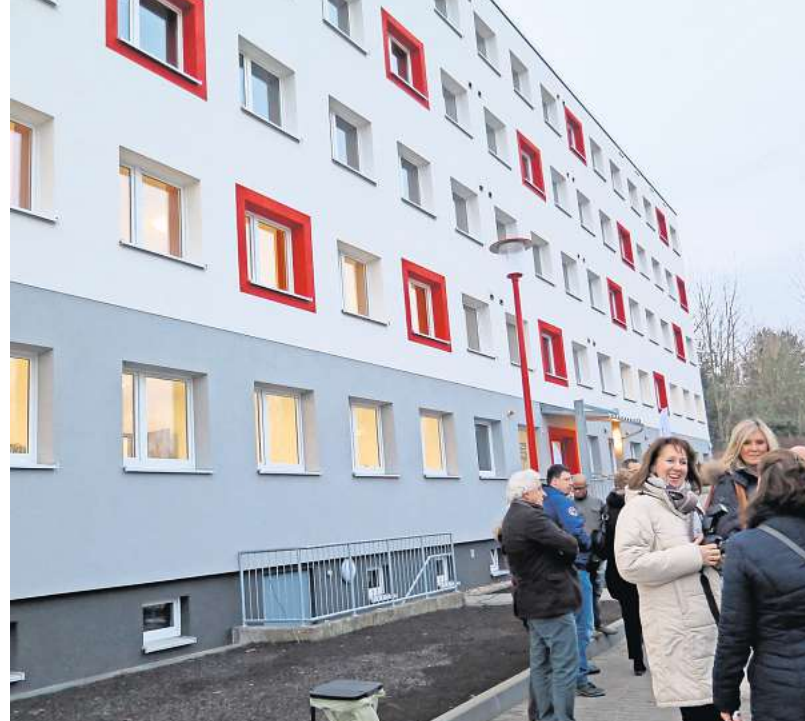
Das Flüchtlingsheim in der Luckenwalder Anhaltstraße wurde saniert. Es befindet sich in Trägerschaft des DRK. FOTO: ELINOR WENKE
